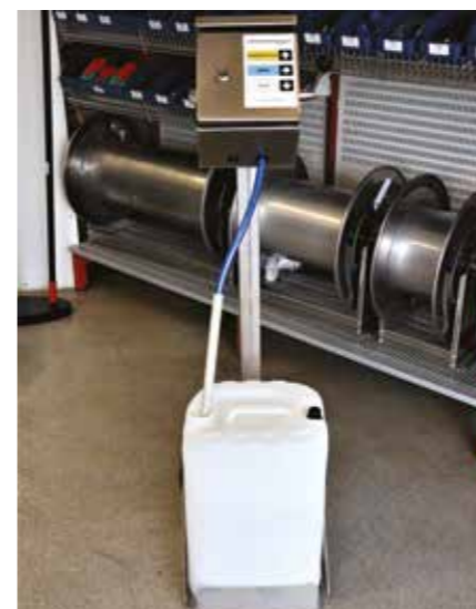
▲ Doseringsystem for desinfisering og vaskemiddel for industrivasking.
