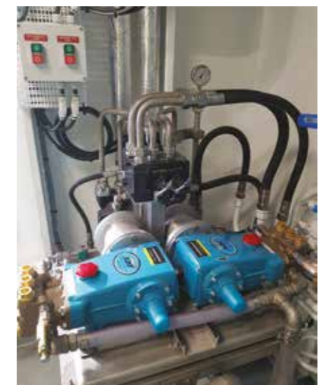
▲ Pumper av modell Fat Pumps, med en kapasitet på 150 bar og 38 l/min.
